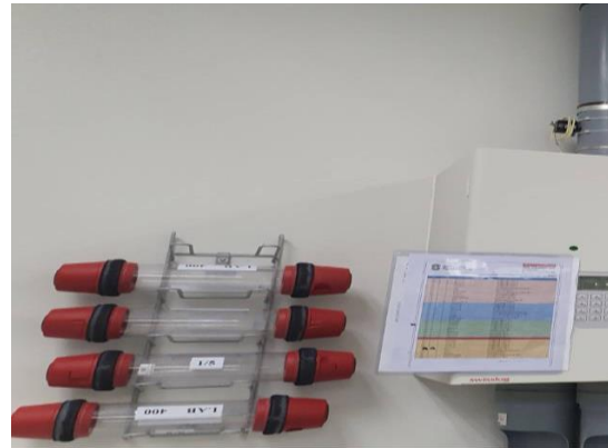
Total Automation การส่ง LAB ผ่านท่อลม
