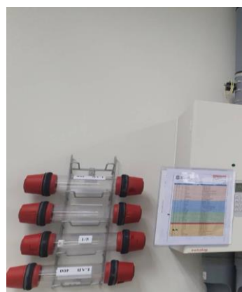
Total Automation การส่ง LAB ผ่านท่อลม
